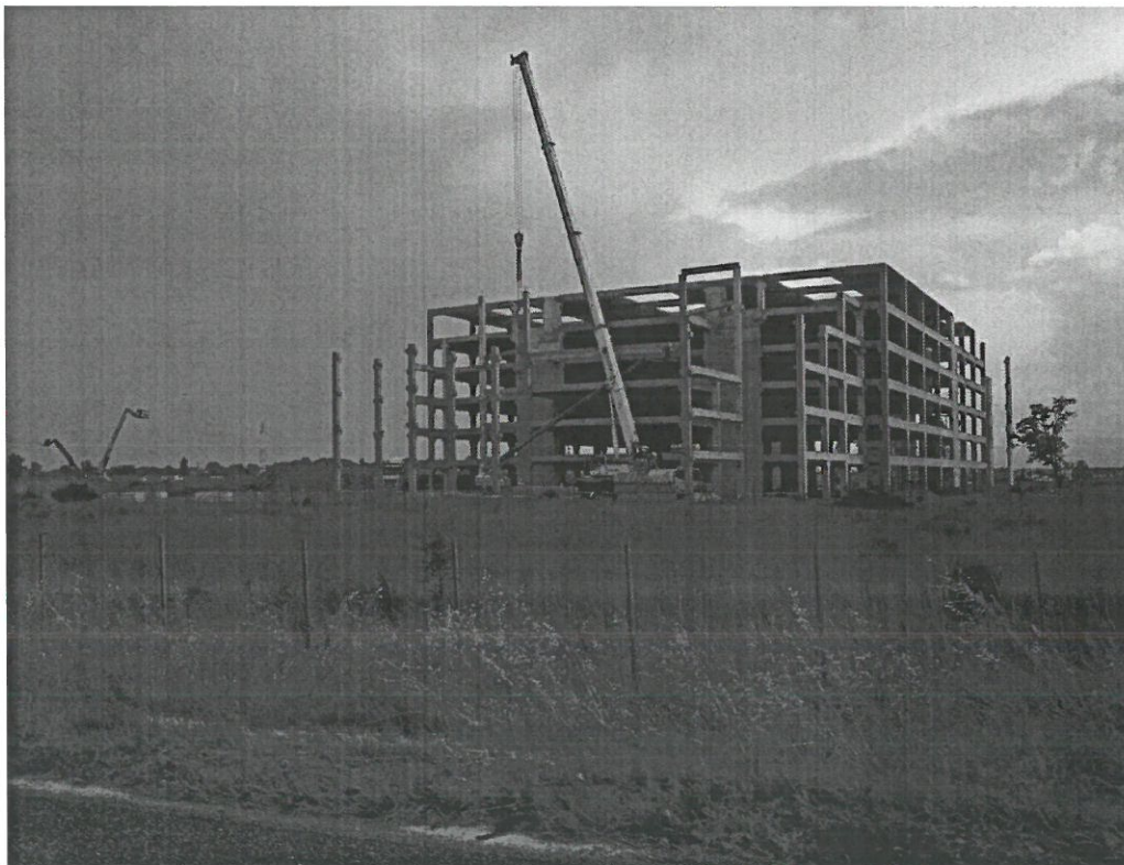
Figura 5: Fotografie dello stato del cantiere, lato nord (autostyrada A1) al 31 maggio 2018
